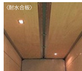
25 天井部簡易断熱材+耐水合板
