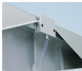
19 フロント雨水受け
