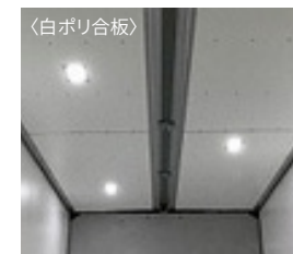
26 天井部簡易断熱材+白ポリ合板
