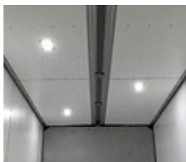
22 内張り白ポリ合板(天井)
