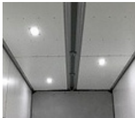
22 内張り白ポリ合板(天井)
