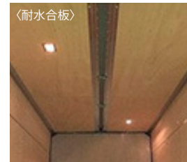
25 天井部簡易断熱材+耐水合板
