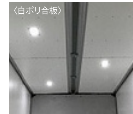
26 天井部簡易断熱材+白ポリ合板
