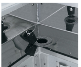
32 水抜き穴 (ゴム栓付)
