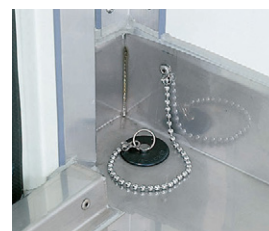
42 水抜き穴(ゴム栓付)
