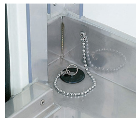
62 水抜き穴[ゴム栓付]
