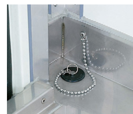
42 水抜き穴(ゴム栓付)
