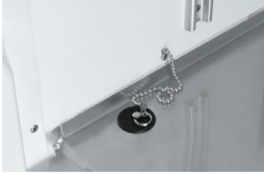
⑭ 水抜き穴追加 (後左側)
